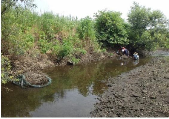
○石倉カゴ撤去前
